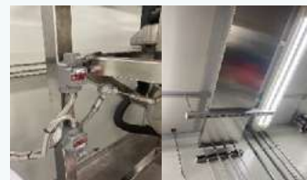
桶槽定位機制，未達密閉定位，設備無法攪拌做動，降低有機物噴濺洩漏及捲夾風險
