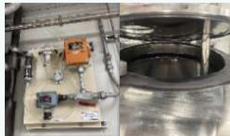
氮氣系統，控制含氧量 < 5vol.% 註2
