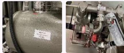
液態原物料、管路輸送溶劑降低逸散風險
